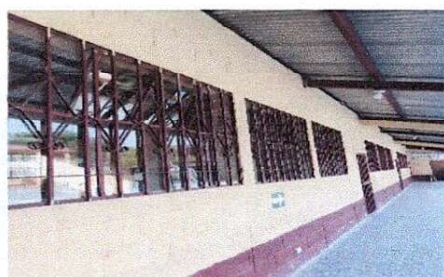
Foto 5: Ventanas de aulas
